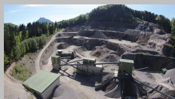
Werk Hof bei Salzburg Hinterseestraße 1 5322 Hof bei Salzburg Tel.: 06229/ 27 83
